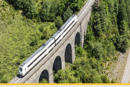
Zaragoza–Canfranc: renovación ferroviaria entre Jaca y Canfranc.
