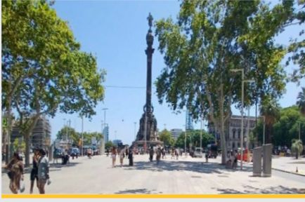
UTE-Rambla 1: reurbanización de la Rambla de Barcelona tramo Colon – Santa Madrona.
