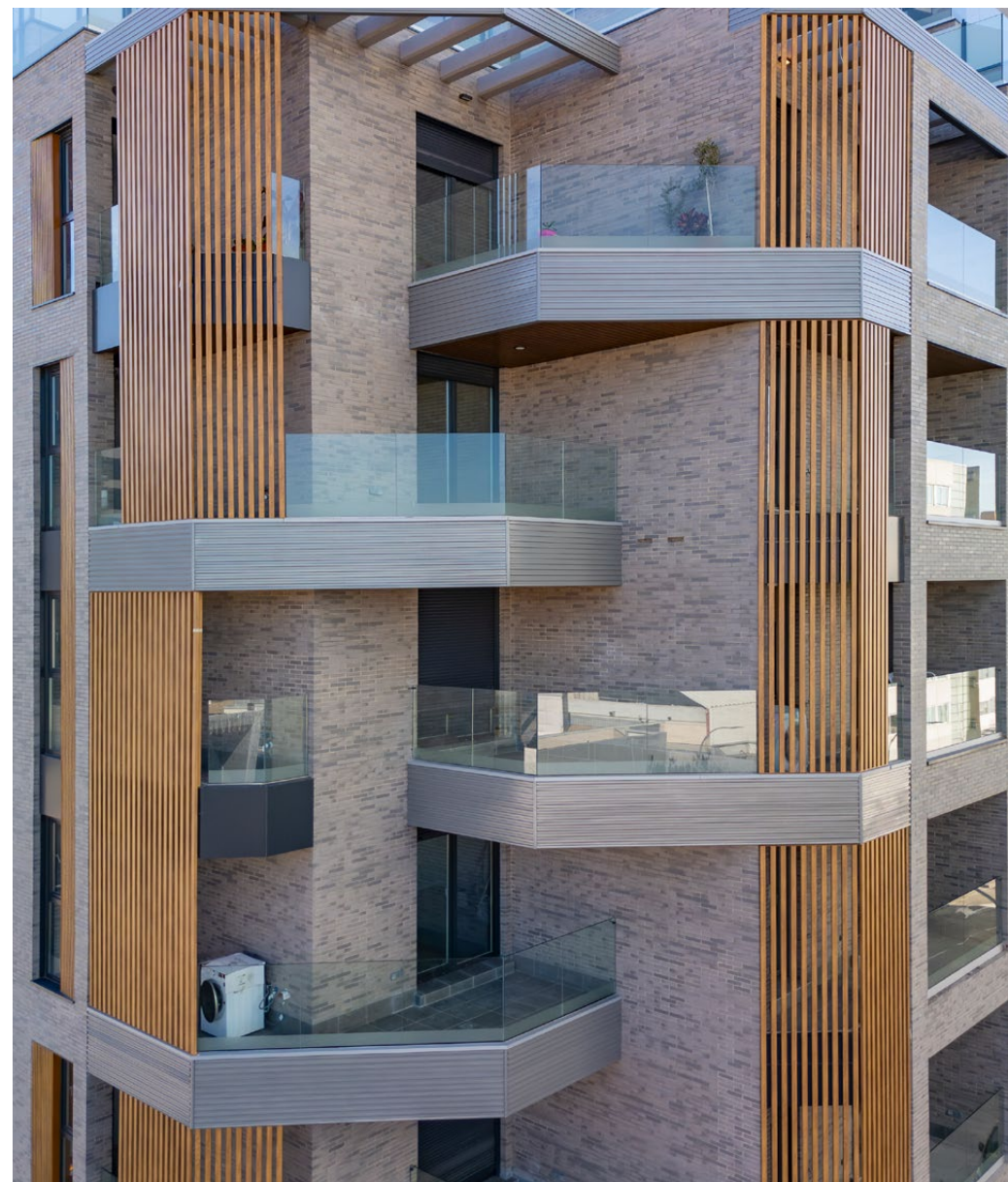
58 viviendas para Premier. Residencial Quinta Avenida en Vallecas (Madrid)
