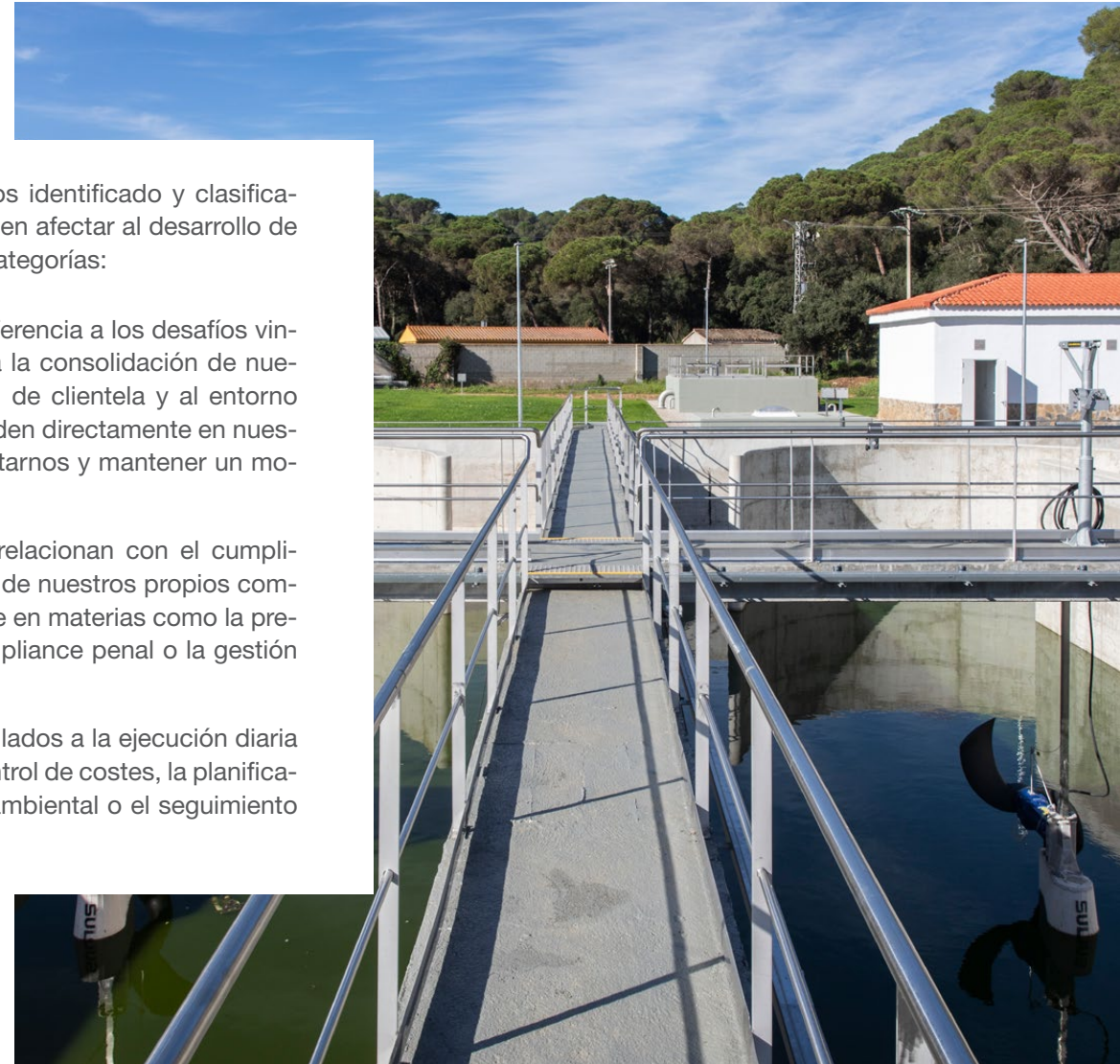
Ampliación y reforma de la EDAR de Tossa de Mar
