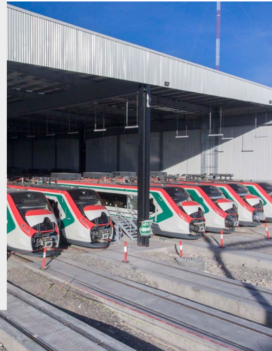
Talleres y cocheras del tren interurbano en Toluca (México)
