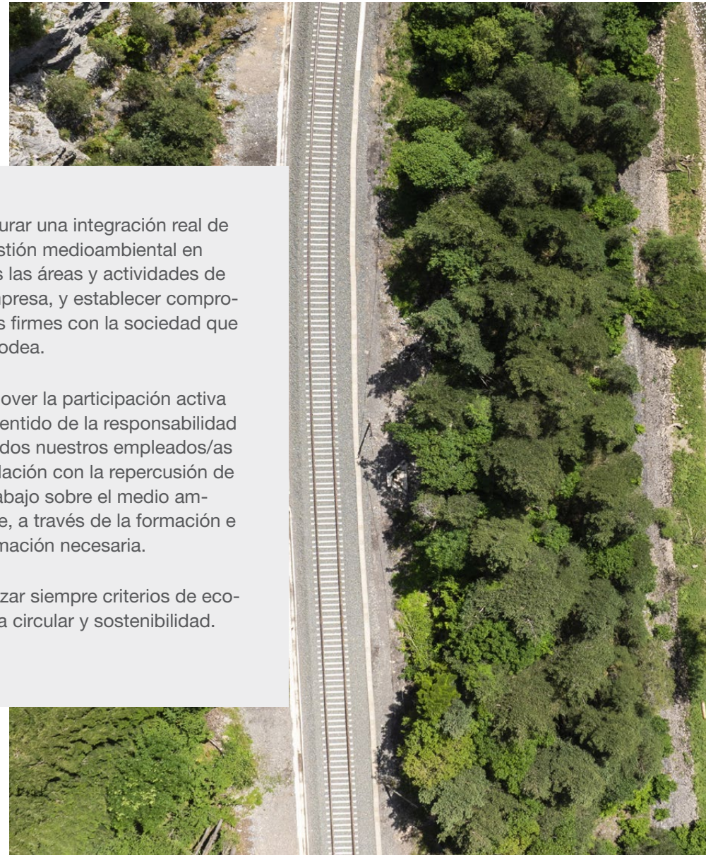
Renovación de la vía entre Jaca y Canfranc, de la línea Zaragoza - Canfranc
