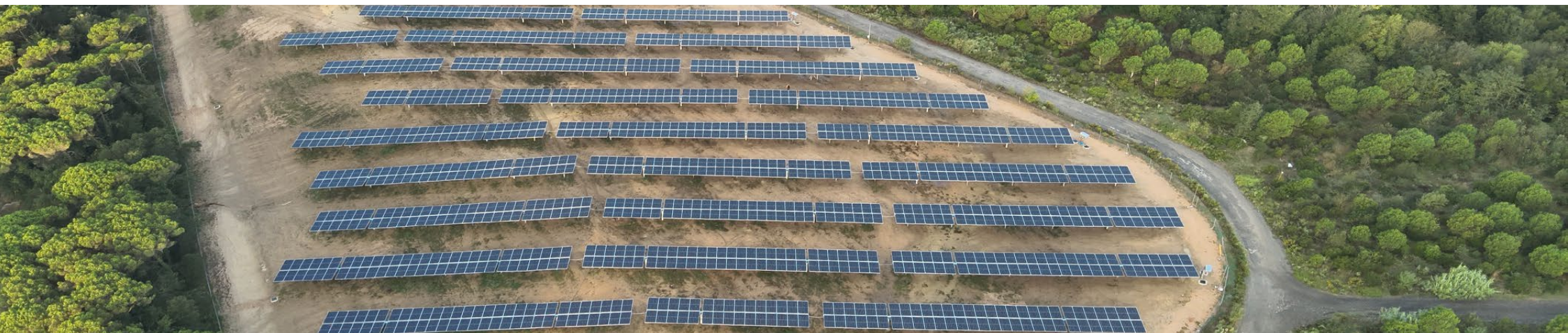
Parque solar fotovoltaico en Vidreres
