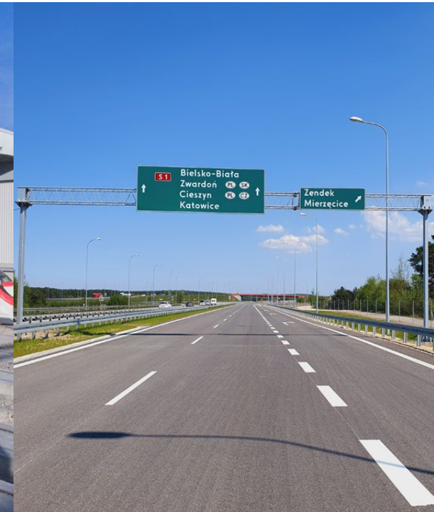
Autovía S1 Pyrzowice
