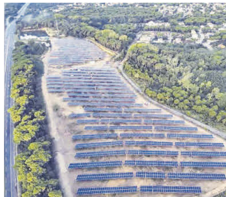
El parc solar de Vidreres.
